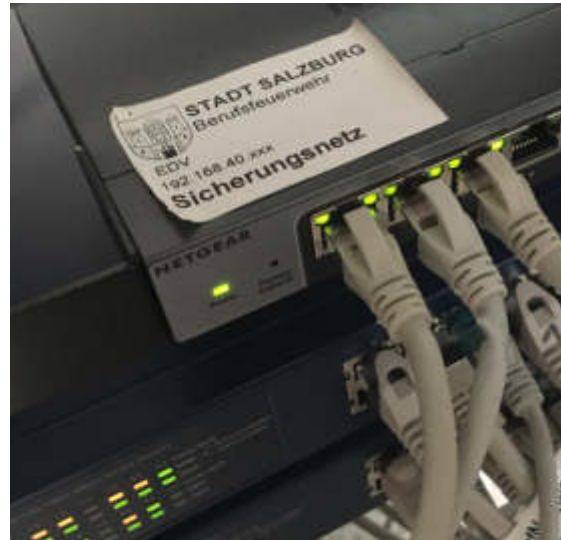
Mehr Sicherheit durch Aufteilung der Datennetze
