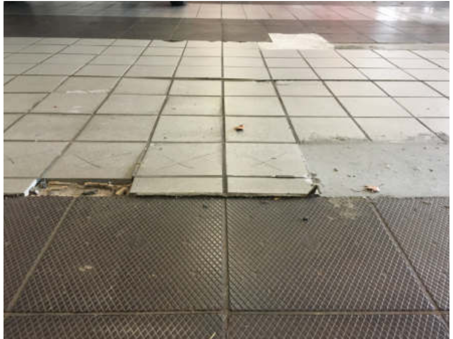
Fahrzeughalle Wache Schallmoos: Bodenbelag vor der Sanierung
