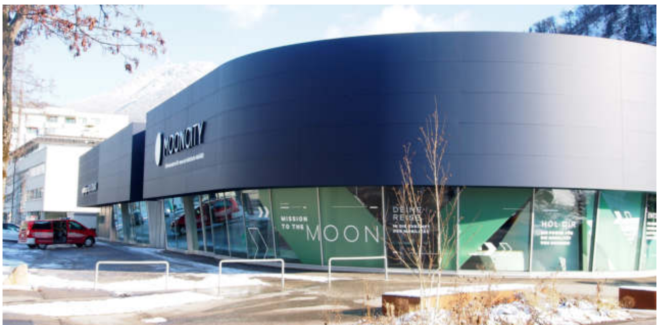
Moon-City: Brandmeldeanlage mit trockener Steigleitung, Gebäude mit besonderen Bereichen (Akkulager und Akku-Quarantäne-Raum)
