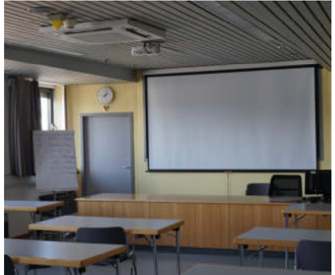
Schulraum mit Klimaanlage und „COVID-19-Bestuhlung“
