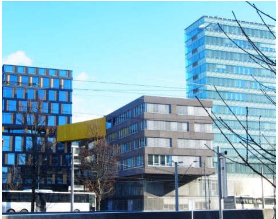
SGKK Turm - Erweiterung der Salzburger Gebietskrankenkasse: Brandmeldeanlage mit Druckbelüftungsanlage, Feuerwehraufzug, Sprinkler- und Gaswarnanlage
