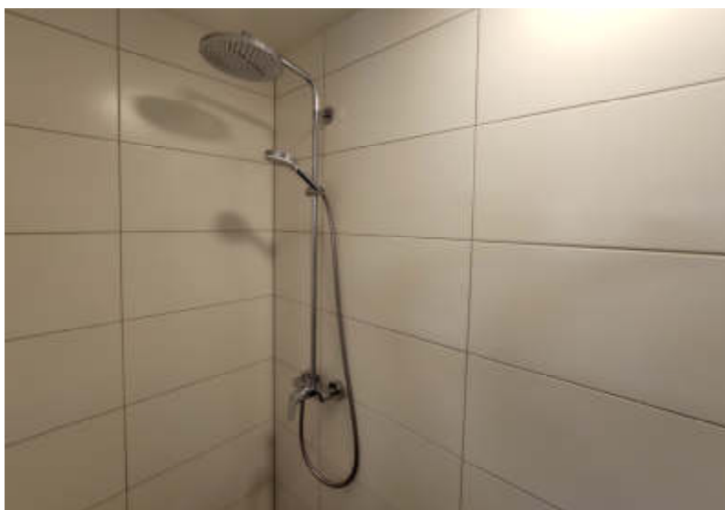
Sanierter Duschkraum in der Feuerwache Schallmoos
