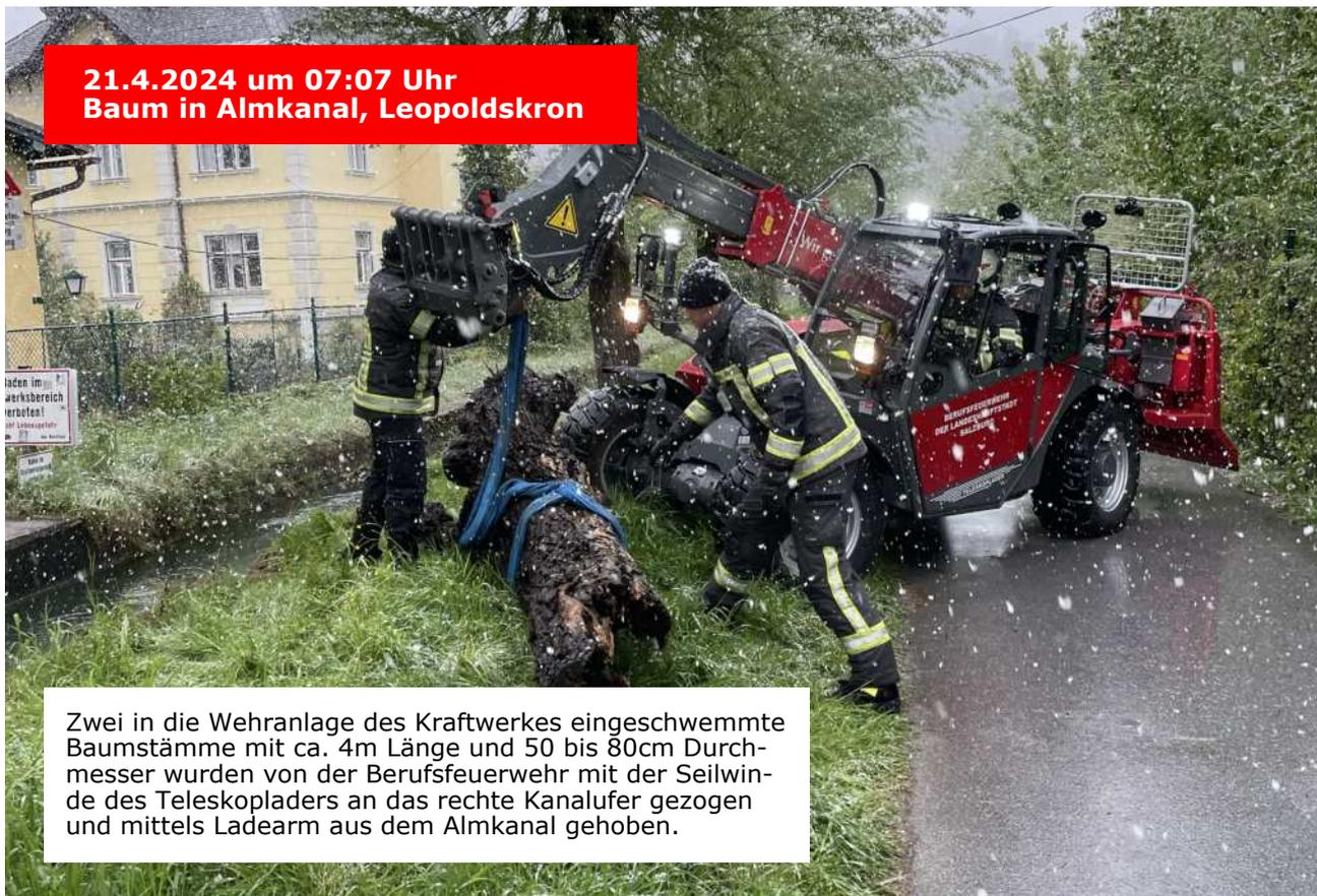
Zwei in die Wehranlage des Kraftwerkes eingeschwemmte Baumstämme mit ca. 4m Länge und 50 bis 80cm Durchmesser wurden von der Berufsfeuerwehr mit der Seilwinde des Teleskopladers an das rechte Kanalufer gezogen und mittels Ladearm aus dem Almkanal gehoben.
