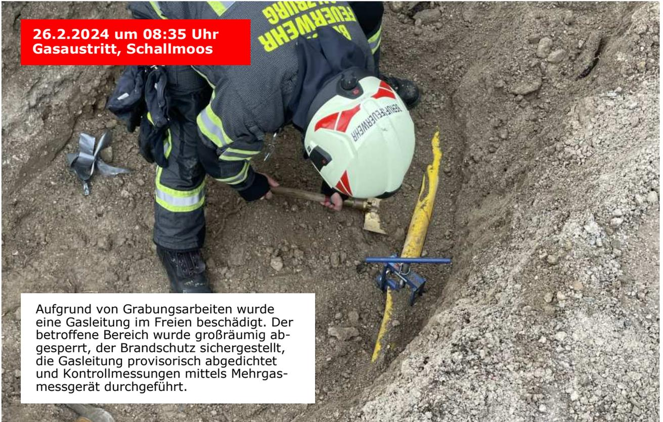
Aufgrund von Grabungsarbeiten wurde eine Gasleitung im Freien beschädigt. Der betroffene Bereich wurde großräumig abgesperrt, der Brandschutz sichergestellt, die Gasleitung provisorisch abgedichtet und Kontrollmessungen mittels Mehrgasmessgerät durchgeführt.
