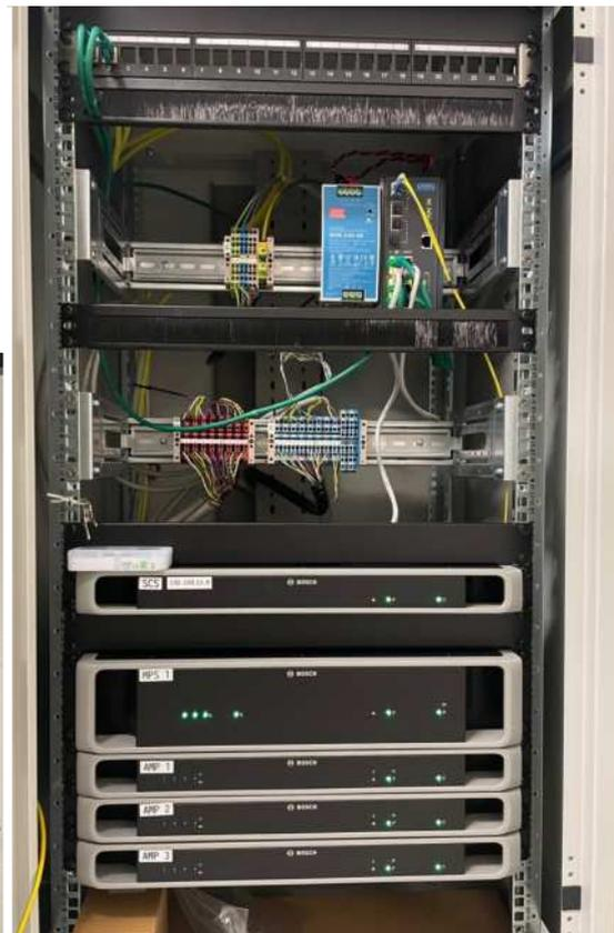
**Notsprechstellen ermöglichen eine Beschallung auch bei Ausfall des Vermittlungssystems (links) und die neue ELA arbeitet im Notbetrieb unabhängig und eigenständig (rechts)**
