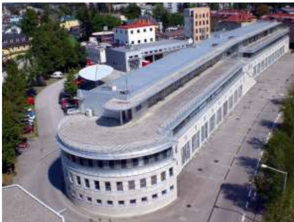
Hauptfeuerwache Maxglan mit Kommando und Leitstelle Jägermüllerstraße 3 5020 Salzburg
