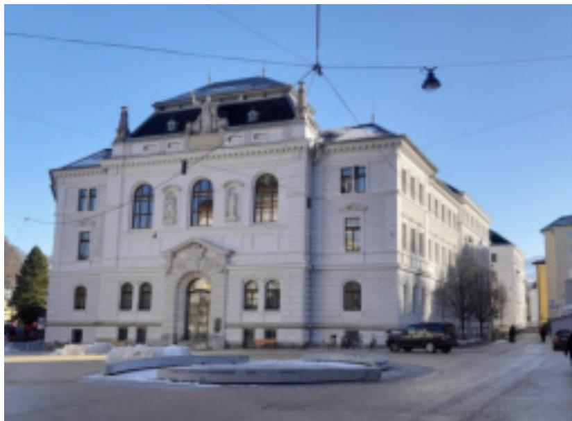
Das Justizgebäude aus dem Jahr 1909 konnte innerhalb von drei Jahren komplett saniert und umgebaut werden. Vom Baubeginn im Sommer 2015 bis zur Fertigstellung im Herbst 2018 wurden 25.000 m<sup>3</sup> Abbruchmaterial plus 5.000 m<sup>3</sup> Aushub abtransportiert und 7.300 m<sup>3</sup> Beton neu verbaut.
