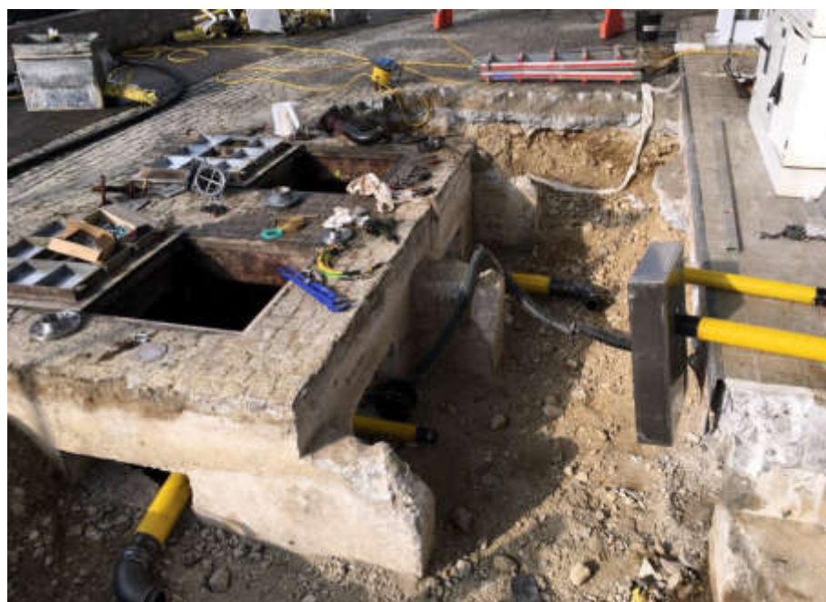
Erneuerung der Zapfsäulen und Errichtung von doppelwandigen Rohrleitungen der Tankstelle im Hof der Hauptfeuerwache
