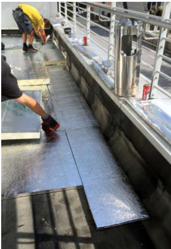
Verlegung der Gefälledämmung auf der neu errichteten Abdichtungs- und Wärmedämmungsebene
